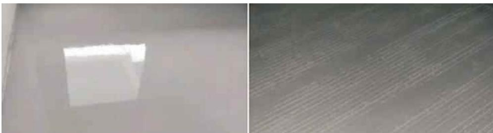
石膏基自流平的色差是由于施工时自流平的流动度控制不一致形成的，在正常使用条件下，随着使用，色差会变浅。
