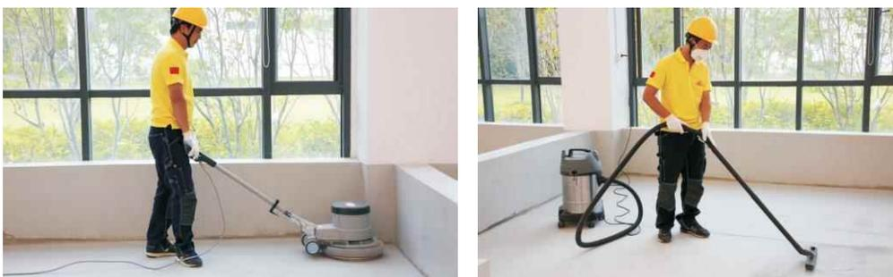
先用打磨机将起砂的地面打磨一遍，将表面的疏松层打掉，然后清扫干净地面，用吸尘器清除灰尘，使用渗透加固型的界面剂涂刷多道，等界面剂完全成膜后再进行石膏基自流平施工。
