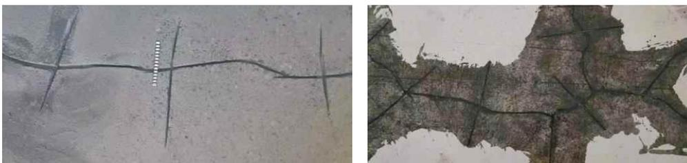
对于基层的裂缝宽度大于0.5mm时，应采用环氧界面剂配合波纹钢片做拉结修补处理。
